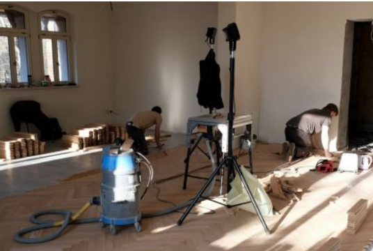
Zum Jahresbeginn wird unser erster Raum im Obergeschoss fertiggestellt
